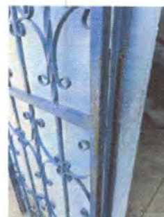
Foto 2: 4.1. Mantenimiento a estructura (lijado, aplicación de pintura)
