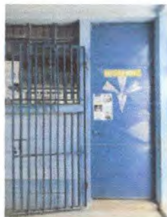
Foto 1: 4.1. Mantenimiento a estructura (lijado, aplicación de pintura)
