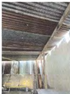
Foto 7: 2.1. Sustitución de estructura de soporte de madera, por metal
