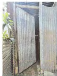
Foto 8: 4.3. Sustitución de puerta
