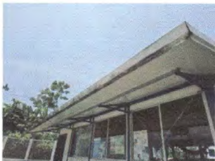
Foto 13: 7.1.Sustitución de canal de metal
