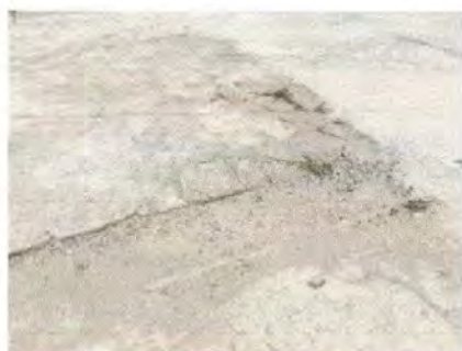
Foto 9: 6.5. Sustitución de piso de torta de concreto
