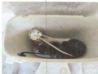
Foto 18: 10.2. Sustitución de accesorios inodoro (contra llave, tubos de abasto y tanque)
