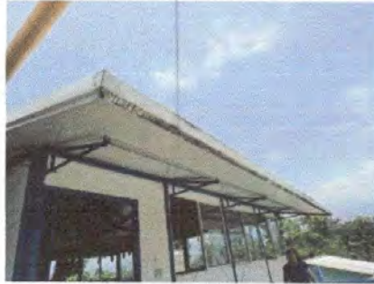
Foto 14: 7.3.Reparación de bajada de agua pluvial, tubo PVC 3
