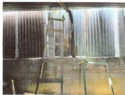
Foto 10: 15.1. Reparación de muro perimetral de block
