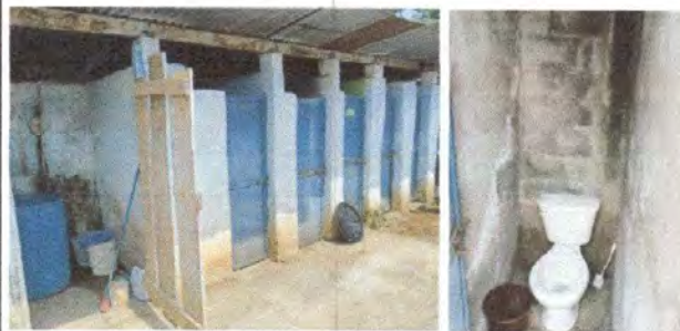
Foto 16: 9.1. Pintura en muros exteriores e interiores
