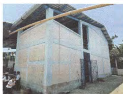
Foto 4: 9.1. Pintura en muros exteriores e interiores
