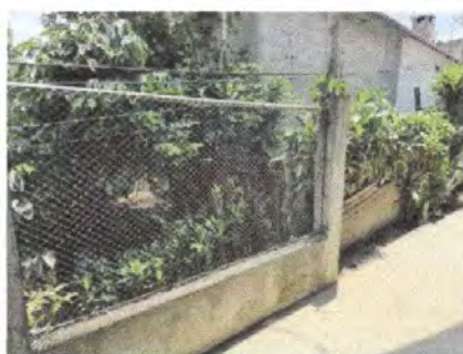
Foto 11: 15.2. Reparación de muro perimetral de block con tubo hg y malla galvanizada, soleras de humedad y columnas
