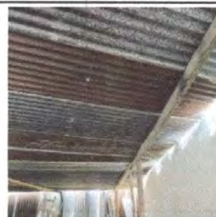
Foto 6: 1.1. Sustitución de lámina, por lámina troquelada aluzinc calibre 26
