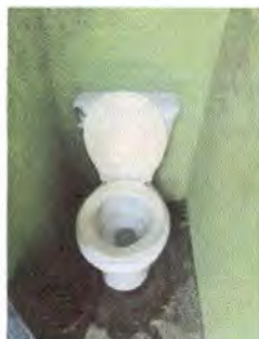
Foto 19: 10.3. Sustitución de inodoro
