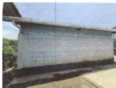
Foto 20: 9.1. Pintura en muros exteriores e interiores
