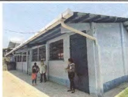
Foto 21: 9.1. Pintura en muros exteriores e interiores
