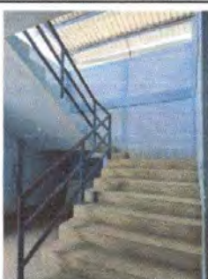
Foto 5: 11.1. Mantenimiento a barandas de metal
